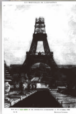
建設途上のエッフェル塔 (Les Merveilles de l'Exposition de 1889; Histoire Construction)
